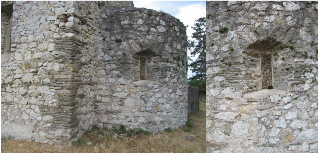
Obr. 22 Místní materiál (pískovce, jílovce, vápence) využitý na kostelíku
